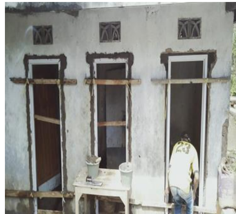
Gambar 11. Proses Pembangunan MCK di Tanjung Sari
