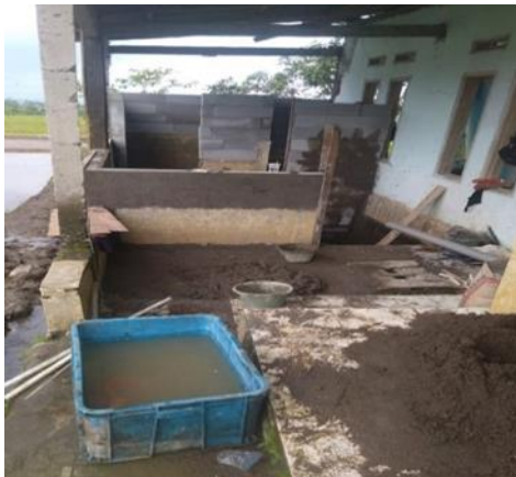
Gambar 10. Proses Pembangunan MCK Di Selahuni
