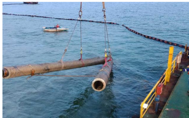
Gambar 4. Patahan Pipa Minyak Karena Tergerus Jangkar Kapal 19
