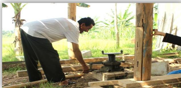
Gambar 4.19 *Utoh Yan* menunjukkan dongkrak yang digunakan untuk mengangkat *tameh*
