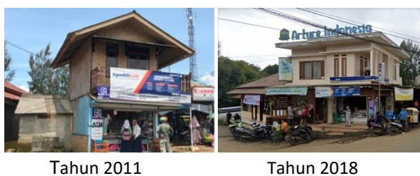
Gambar XIV. Perubahan Tampak Bangunan Sumber: Hasil Survei, 2023.
