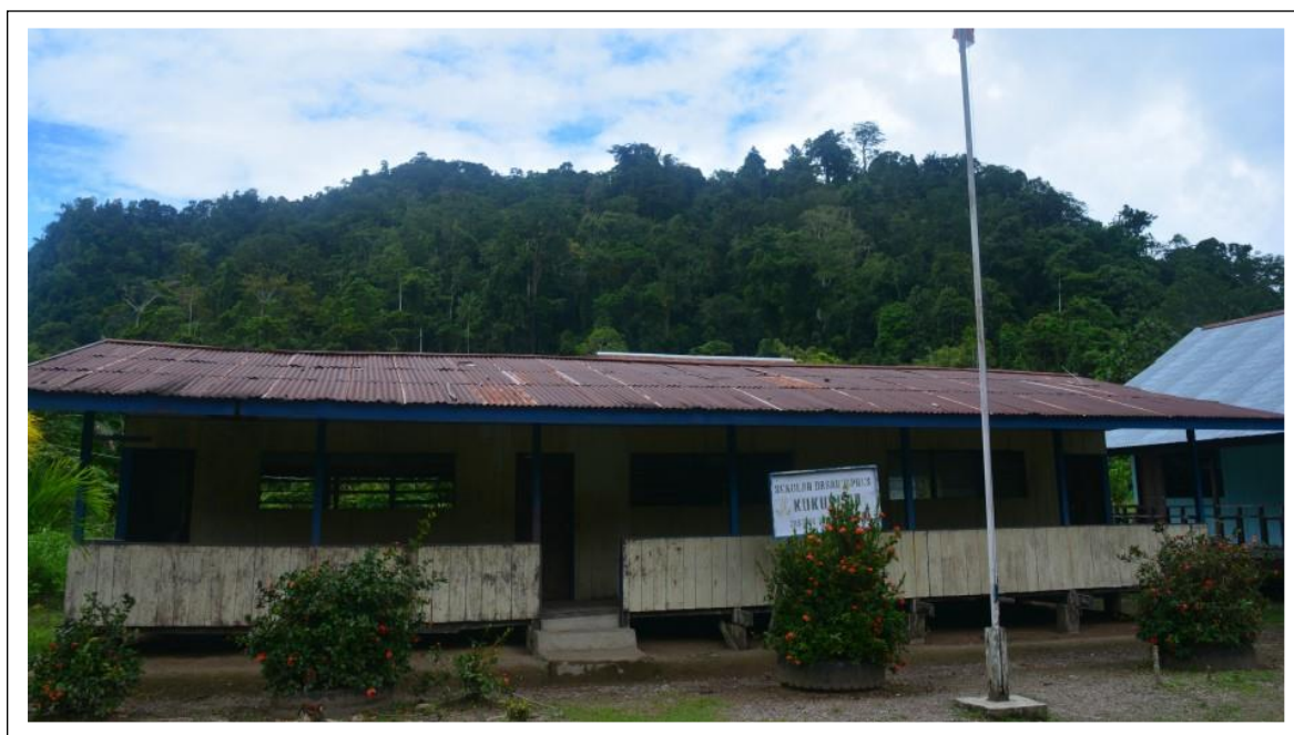
Gambar 2. Kondisi Bangunan Kelas di Distrik Wasior, Kab. Teluk Wondama menjadi saksi kesenjangan pemerataan layanan pendidikan di daerah berbasis 3T.
