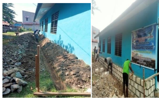
Gambar 1. Proses Pembangunan Talud
