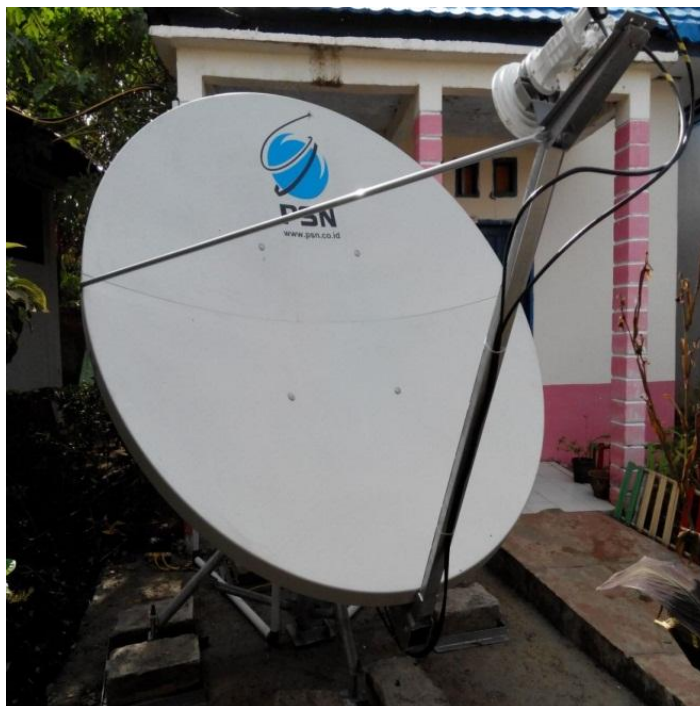
Gambar 4. Antena VSAT yang sudah dirakit
