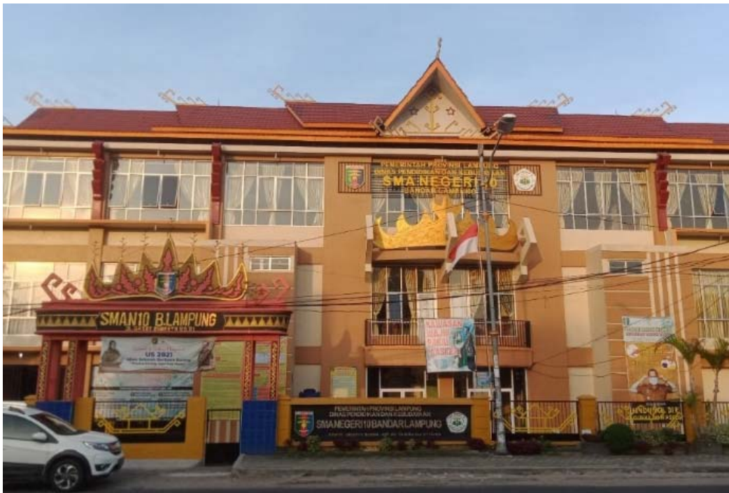
Gambar 8. Tampak Depan Gedung SMAN 10 Bandar Lampung
