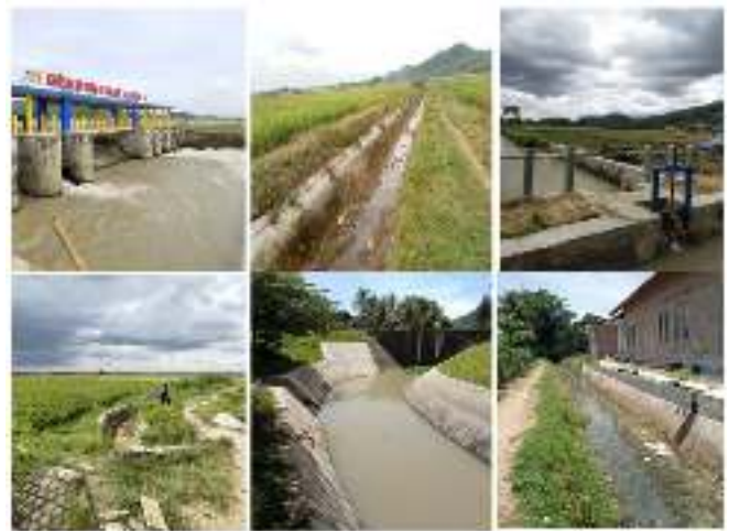
Gambar 2. Kondisi Daerah Irigasi Way Gatel
