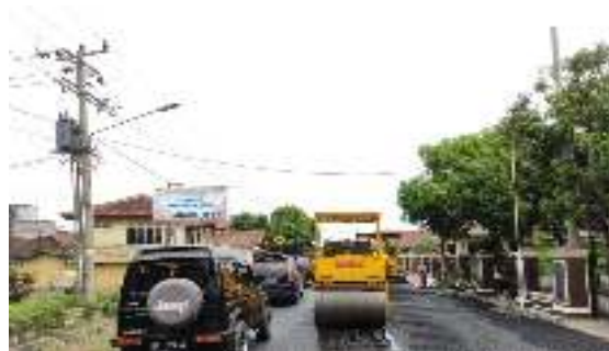
Gambar 9. Pekerjaan Lapis Permukaan AC – BASE
