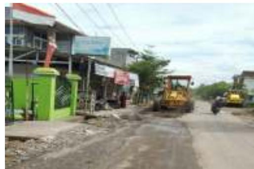
Gambar 8. Lapis Pondasi Bawah dan Lapis Pondasi Atas saat pemadatan
