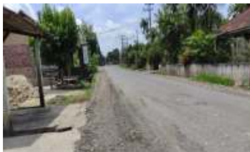
Gambar 7. Pengisian galian dengan agregat A
