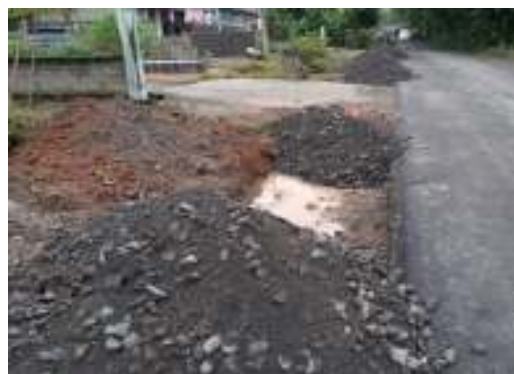
Gambar 6. Pengisian galian dengan agregat B
