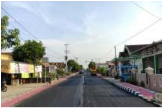
Gambar 10. Pekerjaan Lapis Permukaan AC – WC
