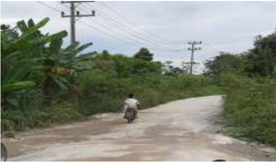
Gambar 1.2 Kerusakan jalan dan tidak terdapatnya bahu jalan serta saluran drainase
