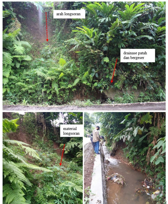
Gambar 7. Longoran di lereng bagian atas jalan Batu Keramat
