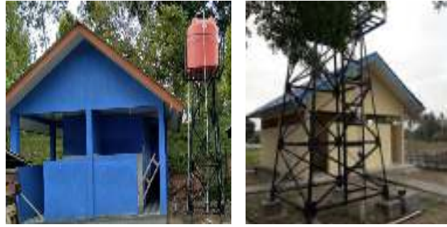
Gambar 3.3 Pembangunan MCK Plus
