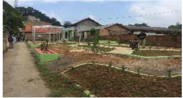
Gambar 3.4 Pembangunan Ruang Terbuka Hijau
