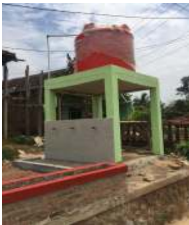
Gambar 3.2 Pembangunan Sumur Bor
