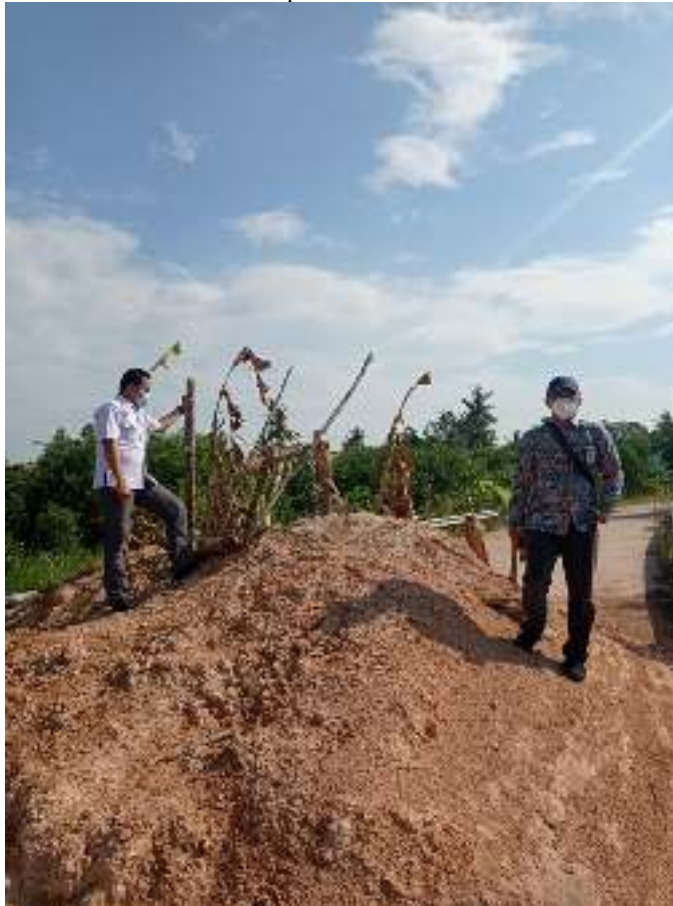
Gambar 1. Foto berlokasi di jalan tol Terbanggi Besar – Pematang Panggang yang ditutup timbunan tanah oleh warga
