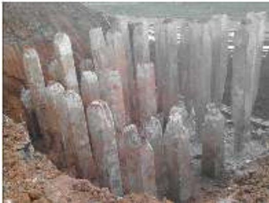
Gambar 2. Pondasi tiang pancang jenis square pile yang digunakan pada proyek Jalan Tol Becakayu
