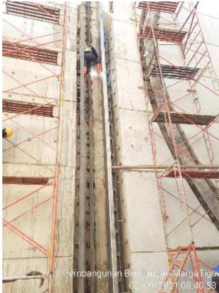
Gambar 1. Pemasangan Frame Pintu dengan metode yang umumnya dilakukan pada pekerjaan pemasangan pintu bendungan (menggunakan block out )
