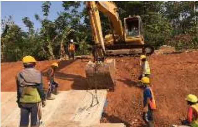
**Gambar 2.** Pemasangan beton pracetak dengan bantuan ekskavator
