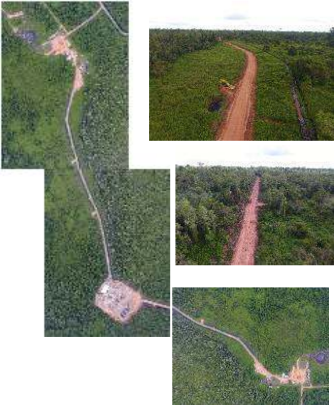
Gambar 8. Hasil konstruksi jalan akses lokasi PAD-X
