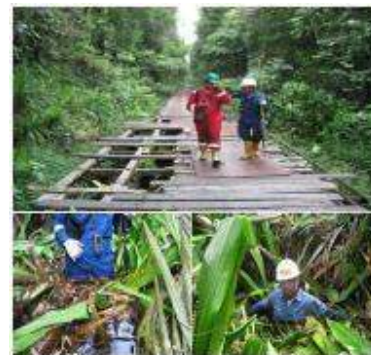
Gambar 2. Kondisi jalan akses eksisting & rawa pasang surut di lokasi PAD-X, Sembakung, Kalimantan Utara
