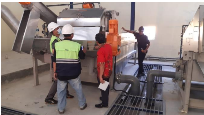
Gambar 3. Pengamatan peran tenaga ahli pada pelaksanaan pekerjaan
