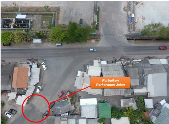
Gambar 8. Kondisi Perkerasan yang harus diperbaiki
