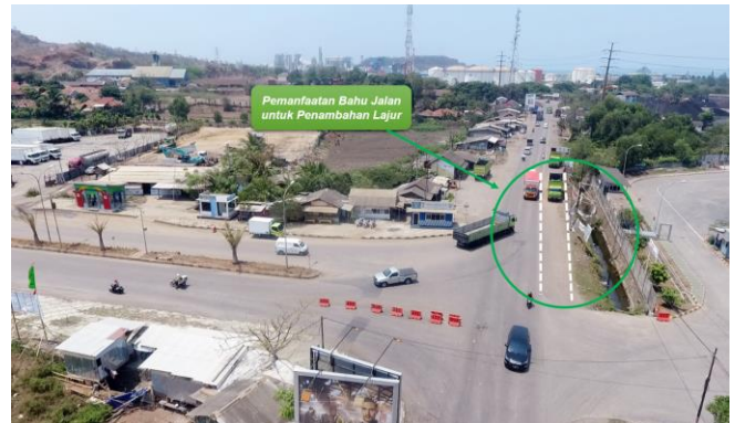
Gambar 11. Pemanfaatan Bahu Jalan untuk Penambahan Lajur/Kaki Simpang
