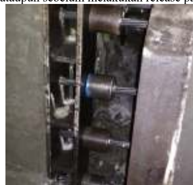
Gbr. 8 Pemasangan wedges
