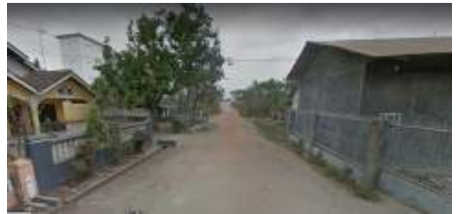
Gambar 6. Kondisi Eksisting Jalan Lingkungan Di Daya Murni
