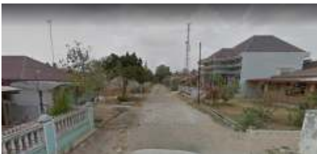
Gambar 4. Kondisi Eksisting Jalan Lingkungan Di Daya Murni
