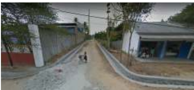
Gambar 5. Kondisi Eksisting Jalan Lingkungan Di Daya Murni
