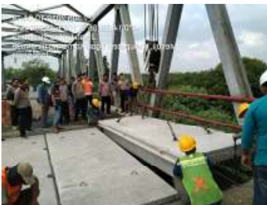
Gbr. 12 Pemasangan Double Tee
