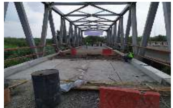
Gbr. 14 Masa curing Beton
