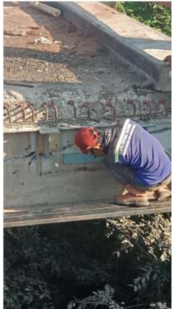
Gbr. 3 Pemasangan Plat
