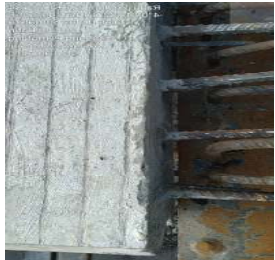
Gbr. 6 Pemasangan shear connector
