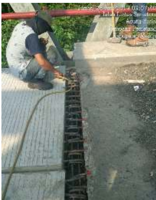
Gbr. 5 Pemasangan shear connector
