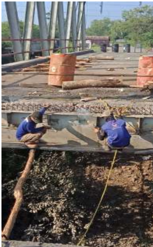
Gbr. 4 Pemasangan Plat Couple
