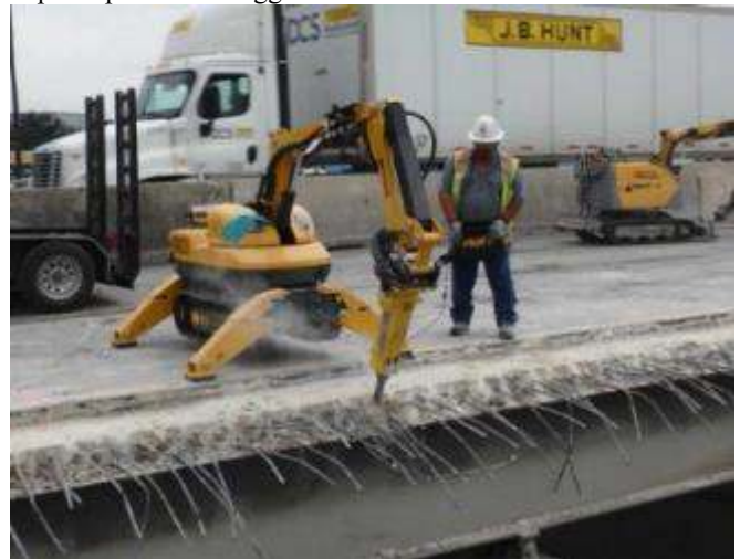
Gambar 30. Penggunaan Brokk 120D
