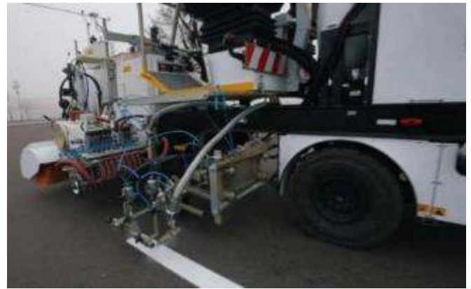
Gambar 23. Pekerjaan Marka dengan Alat Road Marking Machine Kontur 700 TPK
