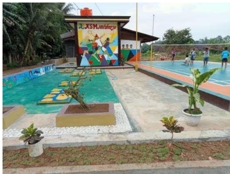
Gambar 15. IPAL Komunal yang terbangun di Kampung Noto Harjo Kecamatan Trimurejo Kabupaten Lampung Tengah
