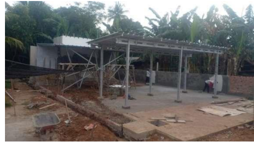
Gambar 24. Pelaksanaan Pembangunan di Kampung Pujo Basuki Kecamatan Trimurejo Kabupaten Lamongan Tengah
