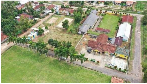
Gambar 21. IPAL Komunal di Kampung Pujo Asri Kecamatan Trimurejo Kabupaten Lamongan dilihat dari udara.
