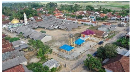
Gambar 10. IPAL Komunal di Kampung Harapan Rejo Kecamatan Seputih Agung Kabupaten Lampung Tengah dilihat dari Udara
