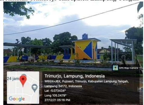
Gambar 20. Hasil Pembangunan IPAL Komunal di Kampung Pujo Asri Kecamatan Trimurejo Kabupaten Lampung Tengah
