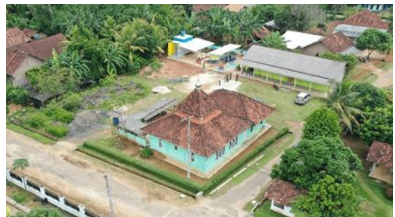
Gambar 26. IPAL Komunal di Kampung Pujo Basuki Kecamatan Trimurejo Kabupaten Lamongan Tengah dilihat dari udara.
