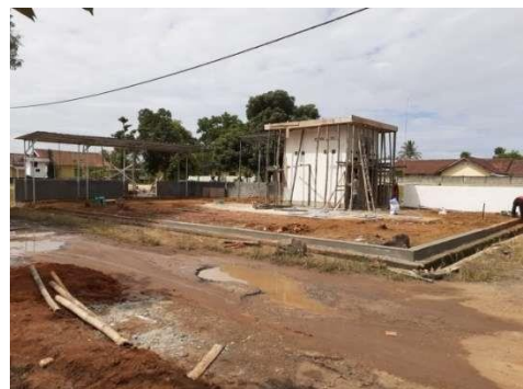
Gambar 19. Pelaksanaan Pembangunan di Kampung Pujo Asri Kecamatan Trimurejo Kabupaten Lampung Tengah
