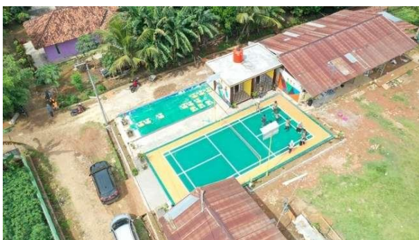
Gambar 16. IPAL Komunal di Kampung Noto Harjo Kecamatan Trimurejo Kabupaten Lampung Tengah dilihat dari udara.
