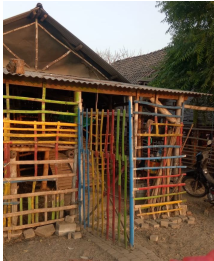
Gambar 6. Kandang Kambing yang Sudah Dicat
