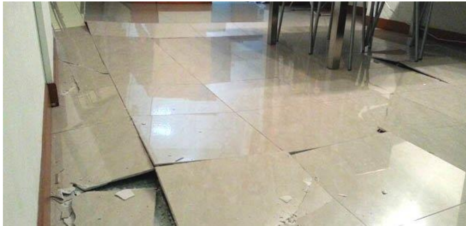
Gambar 1. Popping Up pada Lantai Keramik Rumah
