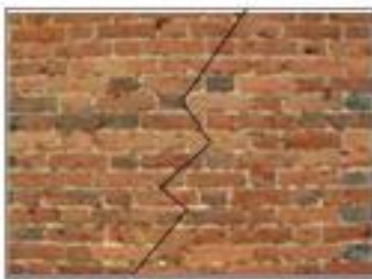
Gambar 1. Pemasangan kawat strimin pada dinding retak
