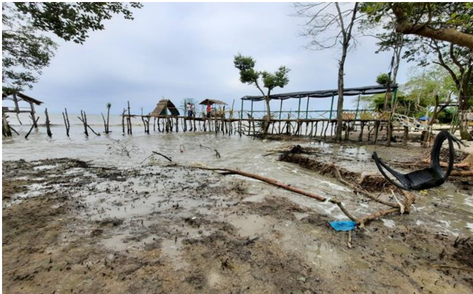
Gambar 1.2 Kondisi Abrasi Pantai
