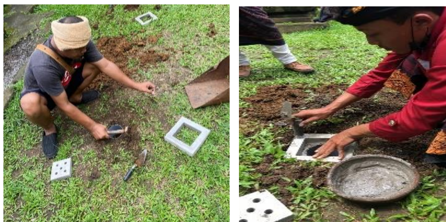
Gambar 3. Pemasangan pipa pada Lubang Biopori
