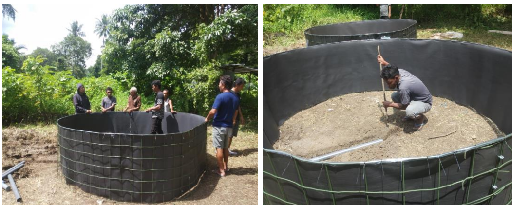
Gambar 6. Pemasangan Kolam Bundar
