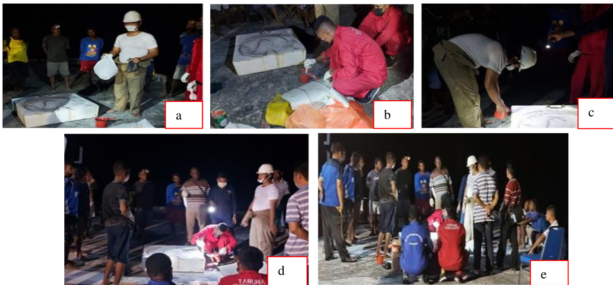
Gambar 9. Proses penambalan kerusakan menggunakan metode Casting
