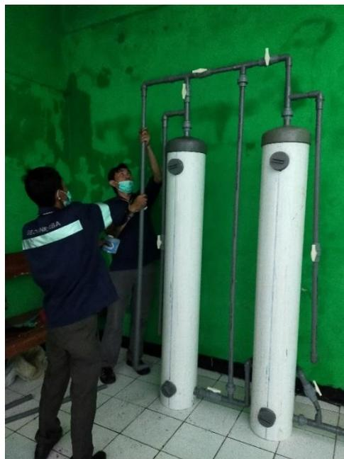
Gambar 7. Proses pembuatan alat pengolahan limbah dengan adsorben karbon aktif
