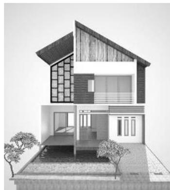
Dalam penyempurnaan desain, kami mempertimbangkan aspek *green architecture* dengan aspek tradisional Sunda. Kedua aspek itu tercermin dari atas sampai ke bawah. Pada bagian atap dibuat tinggi untuk memaksimalkan pengkondisian udara. Atap yang tinggi dapat menyimpan udara kemudian dengan bertahap menyalurkannya ke dalam bangunan. Sehingga hawa dalam bangunan akan terasa sejuk. Selain itu di bagian atapnya pun diberi ventilasi sehingga
