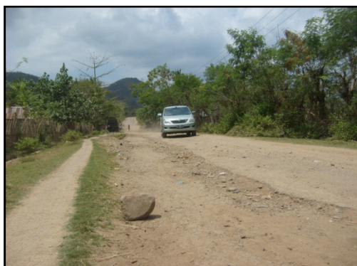
Gambar 2. Kondisi Jaringan Jalan Sumber : Hasil Analisis
