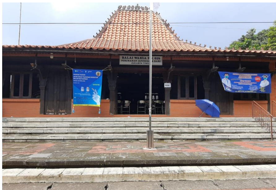
Balai Warga RW 016 Perumahan Jatinegara Baru
