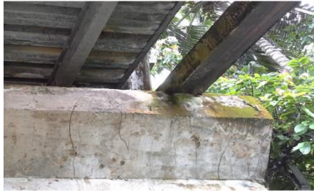
Gambar 12. Kepala Jembatan Idano La'uri atau Pilar Bergerak
