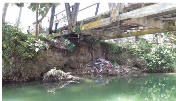
Gambar 13. Pengerusan pada Abutment Jembatan Idano Gewa
