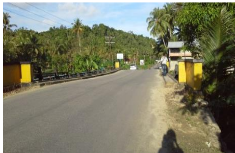
Gambar 4. Lendutan Pelat Lantai pada Jembatan Idano Hili Geho
