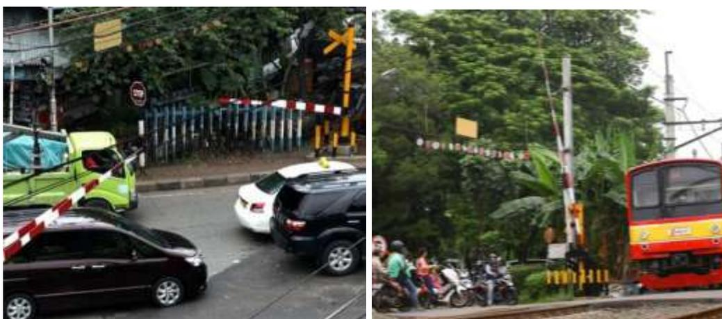
Gambar 1. Kondisi Darurat Palang Pintu Tidak Menutup Sempurna
