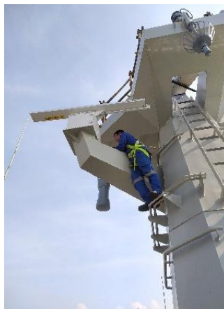
Gambar 3. Pemasangan RADAR
