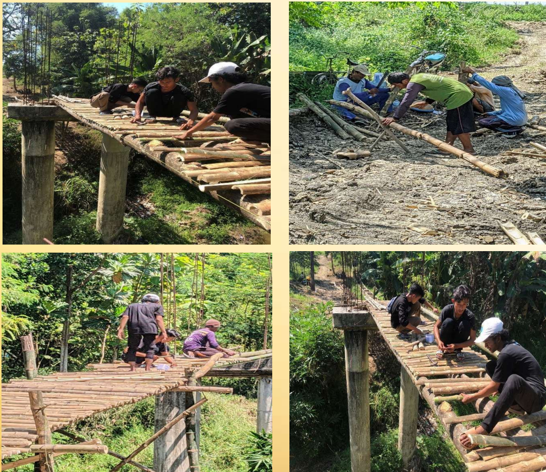
Gambar 1. Proses Pembangunan Jembatan
