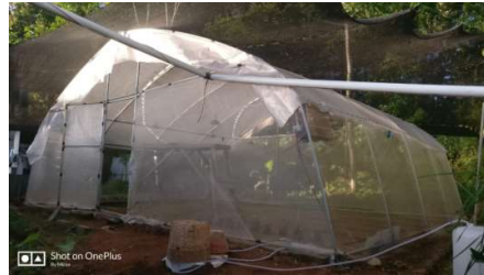
Gambar 2 Pembangunan greenhouse dengan sistem pengairan tadah hujan
