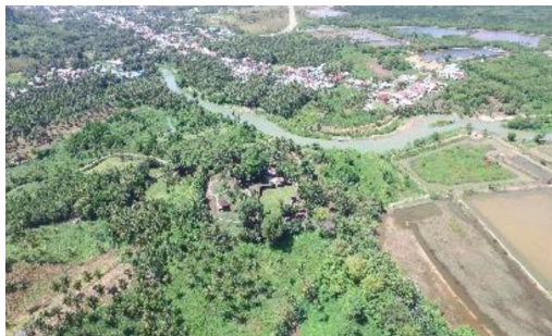
Gambar 4. Foto Tampak Atas Kawasan benteng Orange (Sumber: BPCB, 2018)
