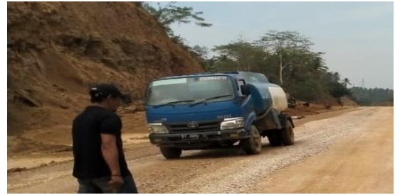
Gambar 8. Penyiraman Material LPB
