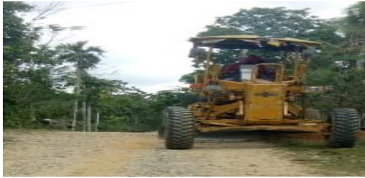
Gambar 4. Proses Penyiapan Badan Jalan B
