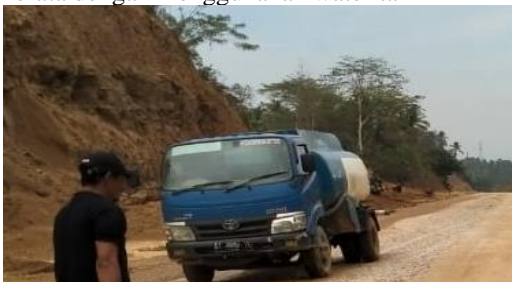
Gambar 12. Penyiraman Material LPA
