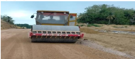
Gambar 7. Pemadatan Menggunakan Vibrator Roller
