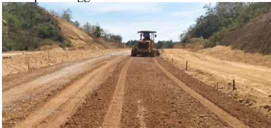
Gambar 6. Penghamparan menggunakan Motor Grader
