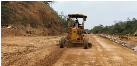
Gambar 10. Penghamparan menggunakan Motor Grader
