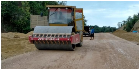
Gambar 11. Pematatan menggunakan Vibrator Roller
