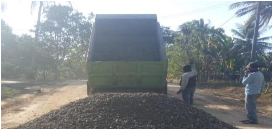
Gambar 9. Pengangkutan Material Agregat Kelas A
