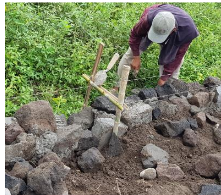
Gambar 1. Pemasangan fondasi batu belah
