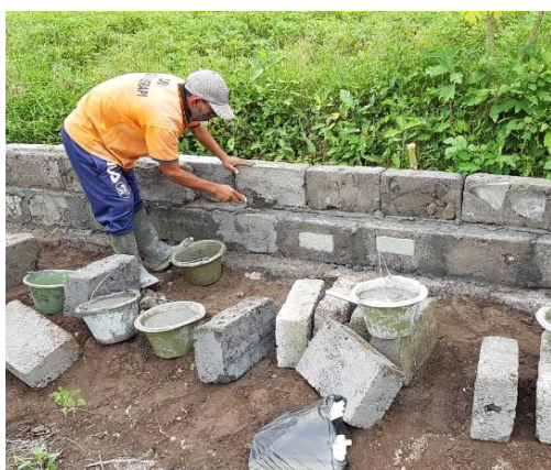
Gambar 2. Pemasangan fondasi blok beton
