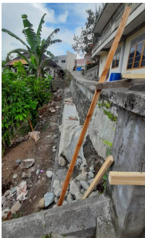
Gambar 1. Pembangunan atau Pengerasan Jalan
