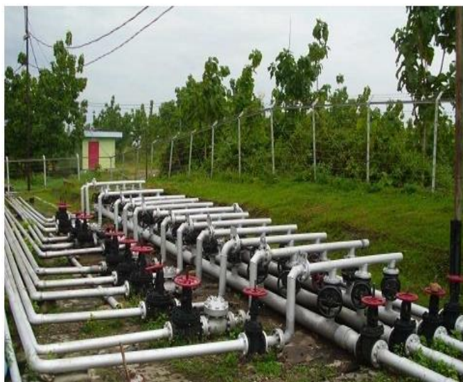
Gambar 1. Manifold dan Header SP IV “X”
