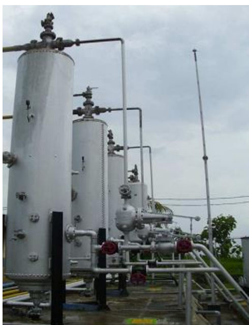
Gambar 2. Separator SP IV lapangan “X”
