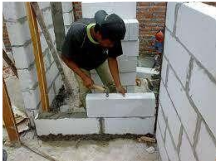
Figure 2. Pemasangan Bata Ringan Untuk Pembuatan Masjid
