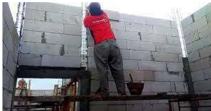
Figure 3. Pemasangan Bata Ringan Untuk Pembuatan Masjid
