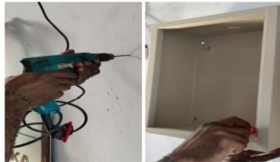
Gambar 4. Proses Pemasangan box panel.
