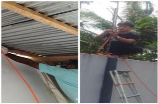
Gambar 6. Proses Pemasangan dan penarikan kabel dari tiang photocell ke box panel.
