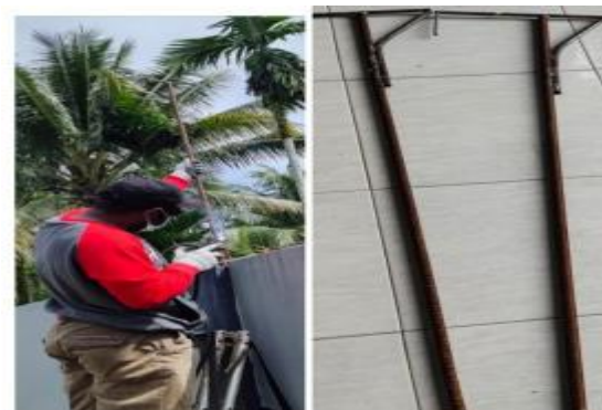
Gambar 5. Proses Pemasangan Tiang Lampu.
