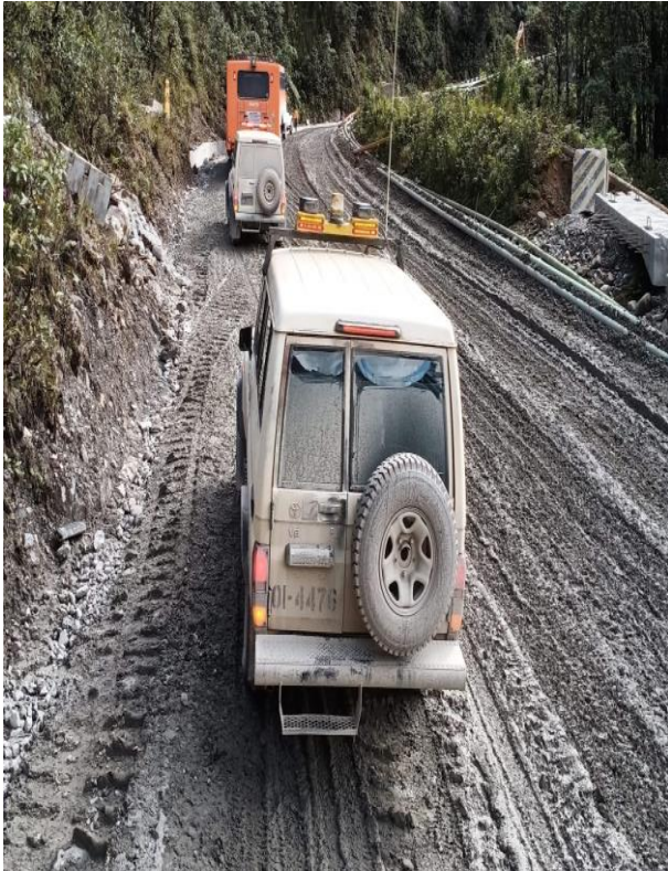
Gambar 7 Kondisi jalan mile 61
