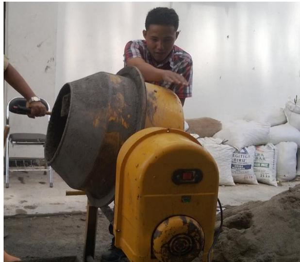
**Gambar 4.** Metode pengadukan beton secara masinal dengan molen
