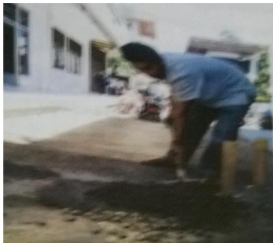
**Gambar 3.** Metode pengadukan beton secara manual
